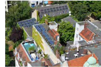
Dachlandschaft zwischen Carl-Schurz-Straße und Judenstraße
