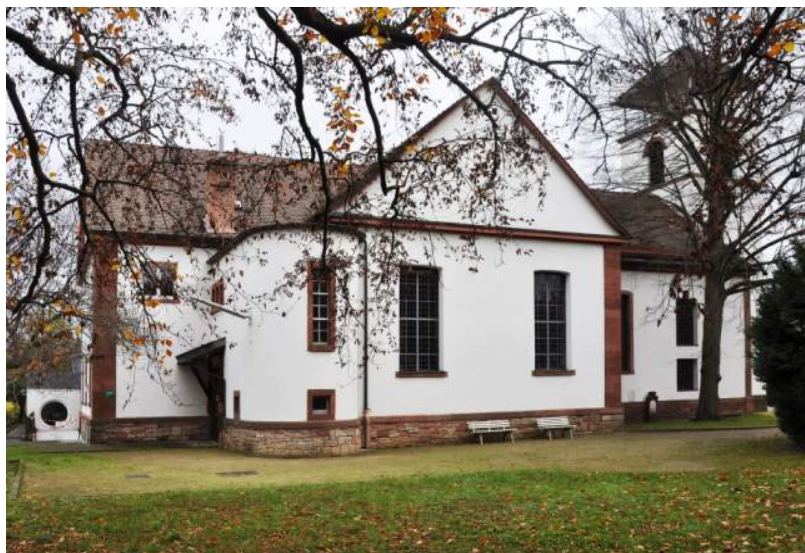
Abbildung 6: Kirche am Marktplatz Kirchgässchen 5 1961 wiedererbaut
