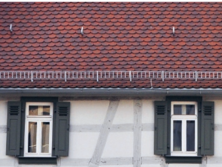
Biberschwanzdeckung im rot-braunen Farbspektrum
