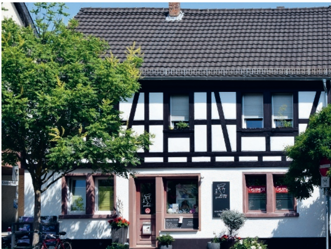
Fachwerkfassade (Lochfassade) mit charakteristischer Doppelfensteranlage, Öffnungen des Obergeschosses axial auf Untergeschoss ausgerichtet; Abgesetzte Sockelzone in dunklerer Farbgestaltung
