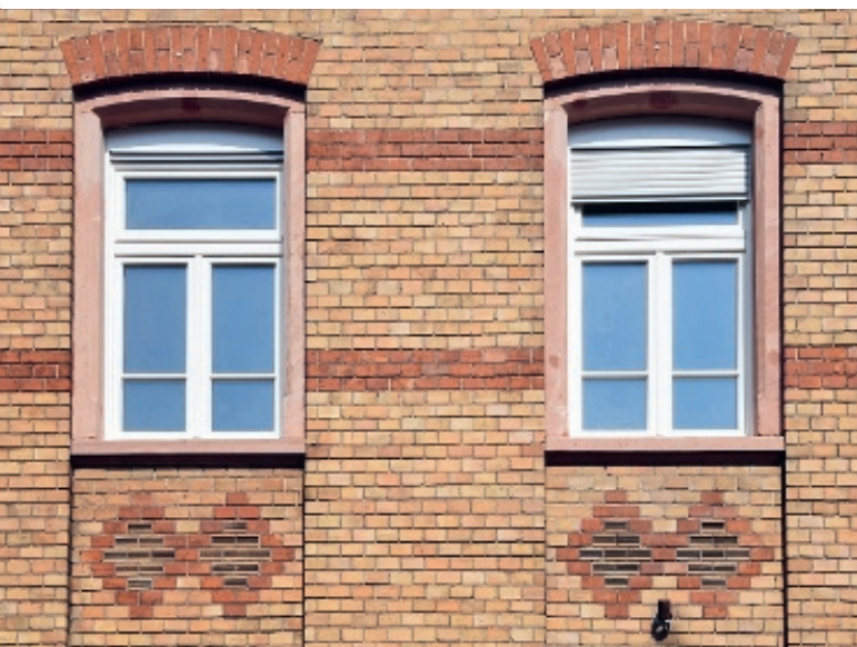
Lochfassade aus Mauerziegeln
