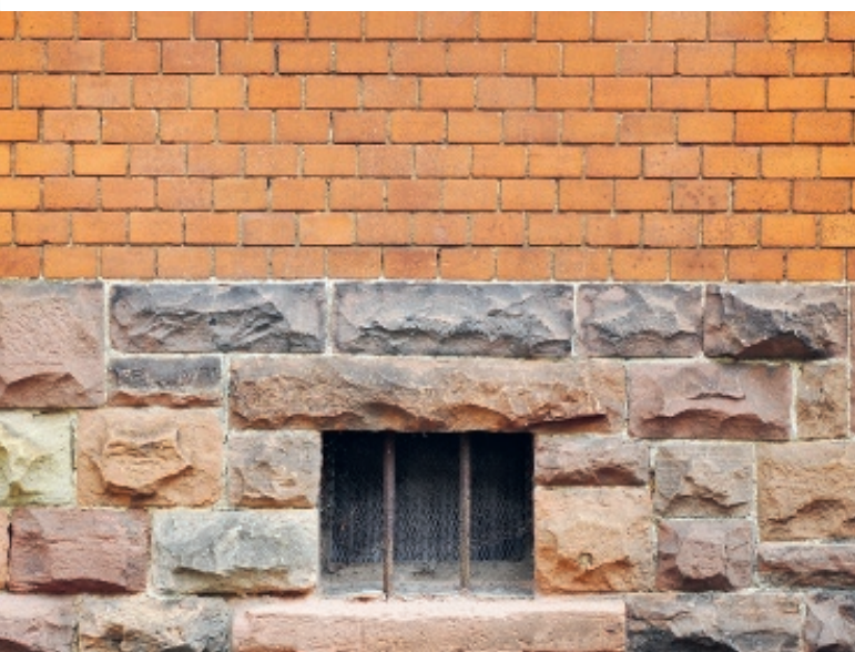
Mauerziegelfassade auf Gebäudesockel aus Naturstein
