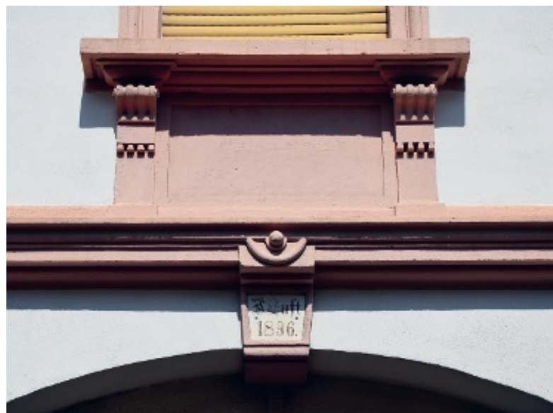
Gesims oberhalb eines Torbogens mit Schlussstein
