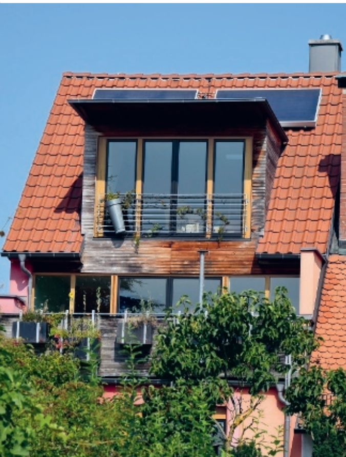
Haustechnische Anlage auf Dachfläche im rückwärtigen Bereich
