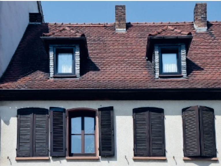
Satteldach mit Biberschwanzdeckung und stehenden Walmdachgauben
