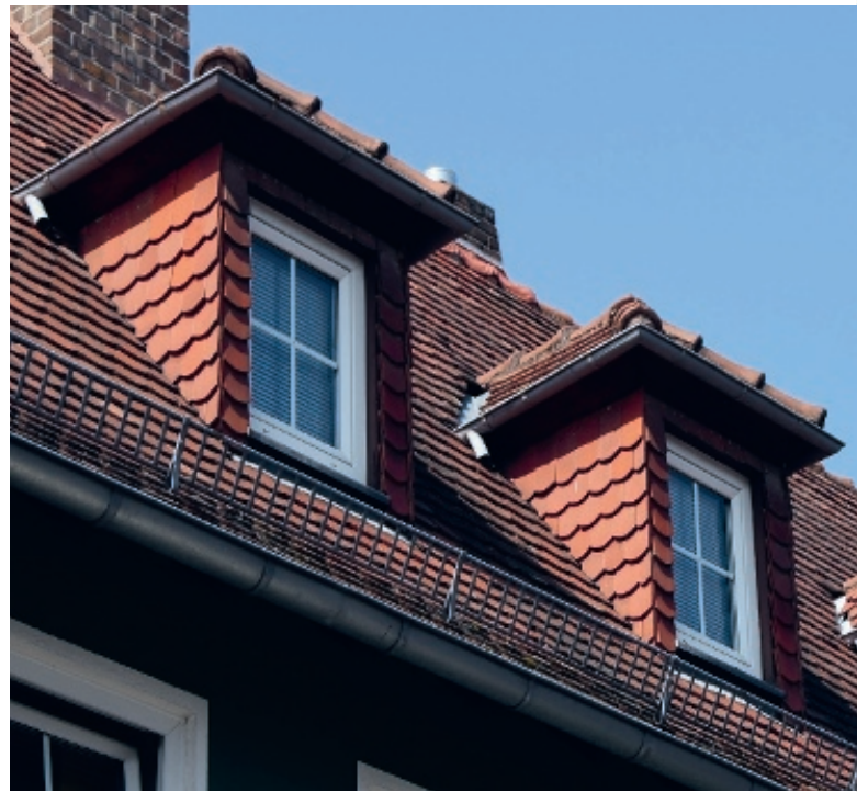
Stehende Walmdachgaube mit Ziegeldeckung und -bekleidung
