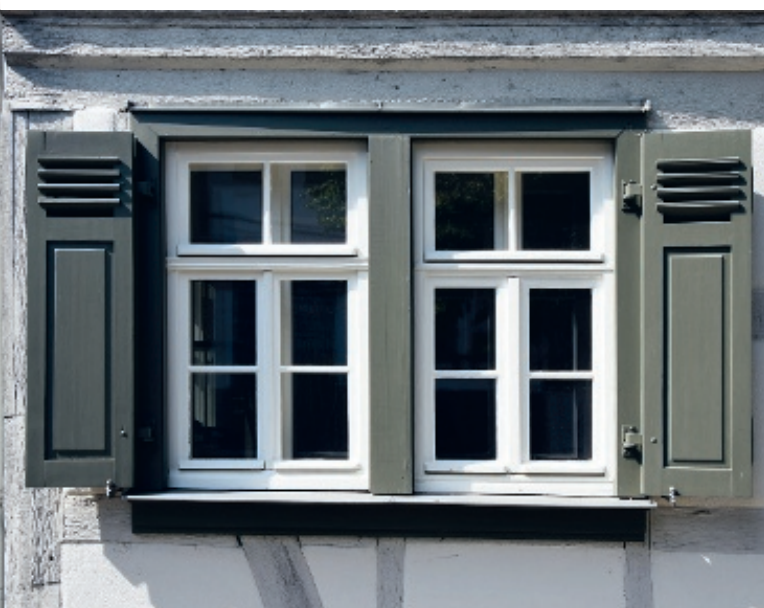
Doppelfensteranlage mit Sprossengliederung und Klapppläden
