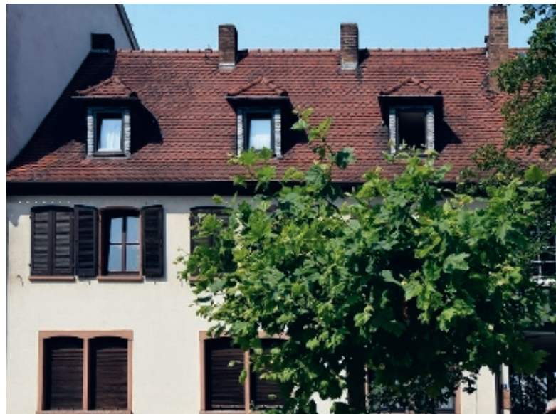
Traufständiges Gebäude mit Traufüberstand
